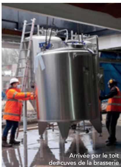
Arrivée par le toit des cuves de la brasserie
